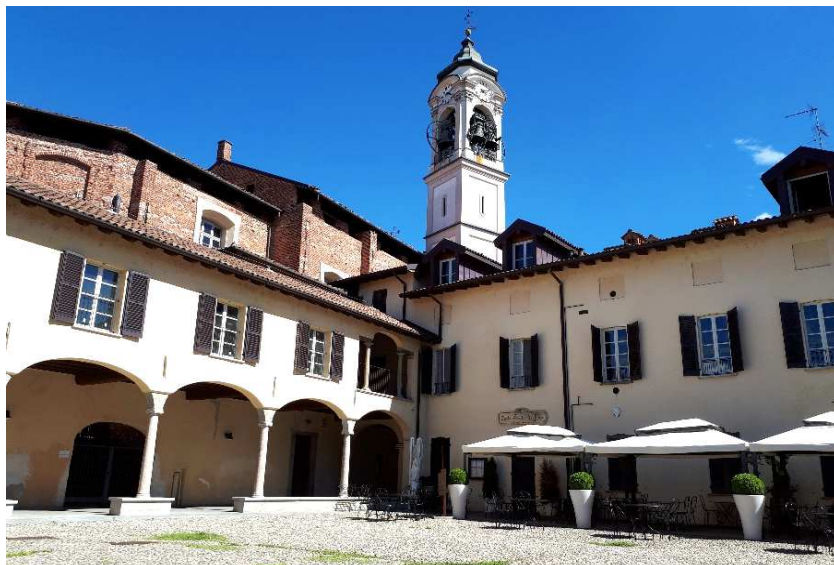
Fig. 36 – Veduta d'insieme del caseggiato della casa parrocchiale con portico (1778-1781)
