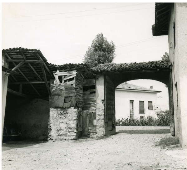
Fig. 13 – Il portale d'ingresso con a lato il pozzo fatiscante (1967)
