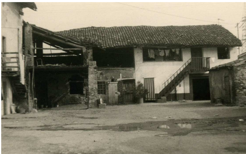
Fig. 14 – Cortile con il fienile ottocentesco parzialmente trasformato in abitazione(1967)
