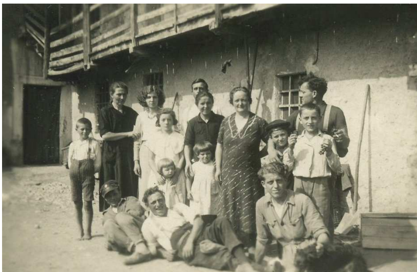
Fig. 12 – Una foto della famiglia Sala (settembre 1936), scattata nel cortile interno del mulino. Si vede il vecchio ballatoio in legno e sul fondo la porta alla cucina dell'osteria
