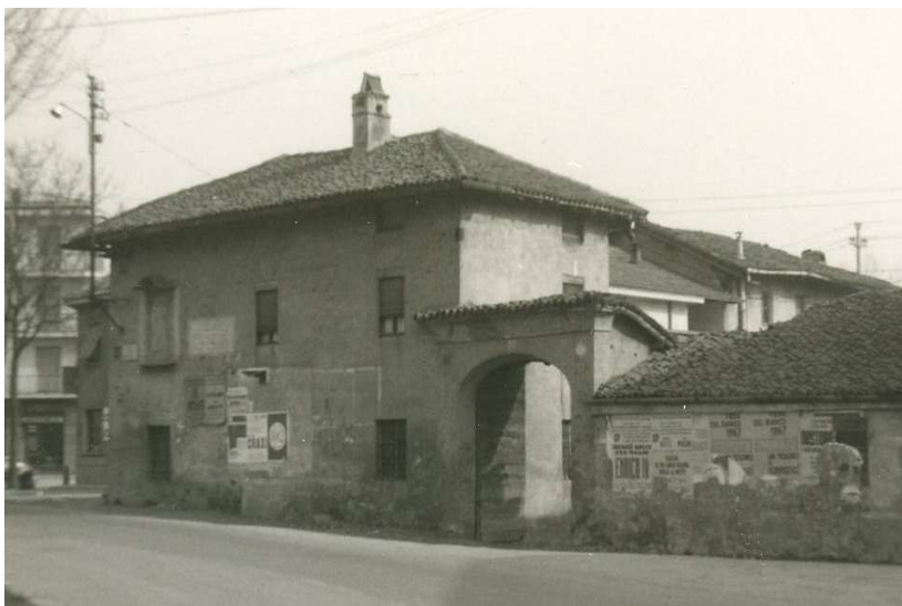
Fig. 2 – Il “Molino Arese”: l’edificio come era nel 1967.
