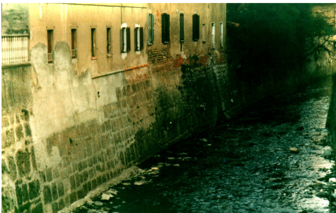
Le sponde in blocchi di ceppo del torrente Seveso a difesa dell'antico "castrum" medioevale
