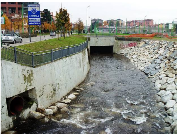
La "fine" del Seveso a Niguarda... Nei pressi di via Ornato ha inizio la tombinatura del torrente
