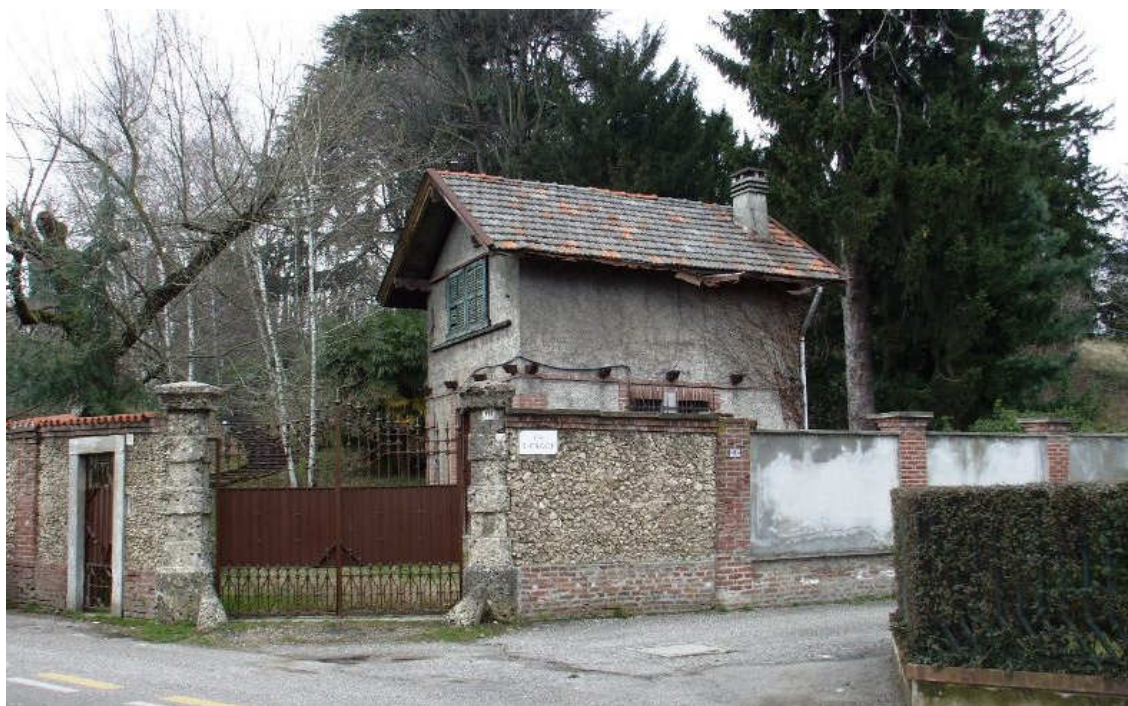
Il casino prima della demolizione nella primavera del 2009
